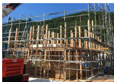
棟上げ(上棟、建前)
