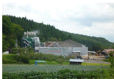
木質バイオマス発電所
