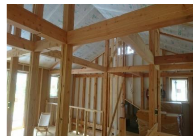
構造材や内装材などに地域材をふんだんに使用して建築
